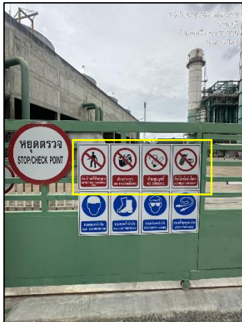
รูปที่ 2-22 ป้ายสัญลักษณ์เตือนห้ามทำงานที่เกี่ยวกับความร้อนเหนือประกายไฟ บริเวณท่อลำเลียงก๊าซธรรมชาติ บริเวณข้อต่อและวาล์ว
