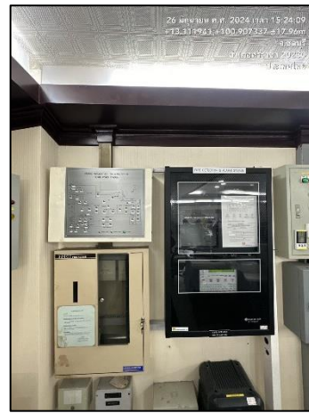
รูปที่ 2-21 อุปกรณ์ตรวจวัดก๊าซไวไฟ (Flammable Gas Detector) และอุปกรณ์ตรวจวัดความปลอดภัยอื่นๆ และ เชื่อมต่อกับสัญญาณฉุกเฉิน ซึ่งควบคุมได้จากศูนย์ควบคุมกลาง (Central Control Panel)
