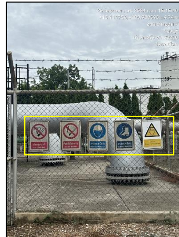
รูปที่ 2-22 ป้ายสัญลักษณ์เตือนห้ามทำงานที่เกี่ยวกับความร้อนเหนือประกายไฟ บริเวณท่อลำเลียงก๊าซธรรมชาติ บริเวณข้อต่อและวาล์ว
